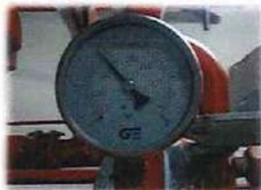
**PRESIÓN CON BOMBAS PRINCIPALES EN FUNCIONAMIENTO (10 kg/cm²).**
