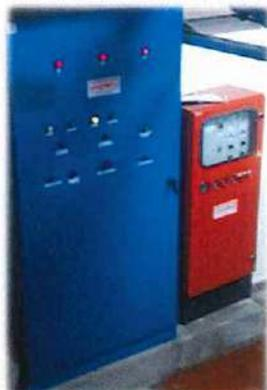
**TABLERO ELÉCTRICO PRINCIPAL: COMANDO ELECTROBOMBA, BOMBA JOCKEY Y BOMBA DE ACHIQUE**
